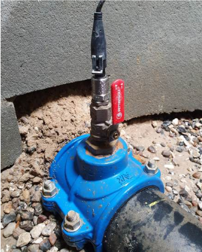
Grazie alla natura wireless dell'IoT, i sensori di pressione possono essere installati in qualsiasi punto critico della rete di distribuzione.
