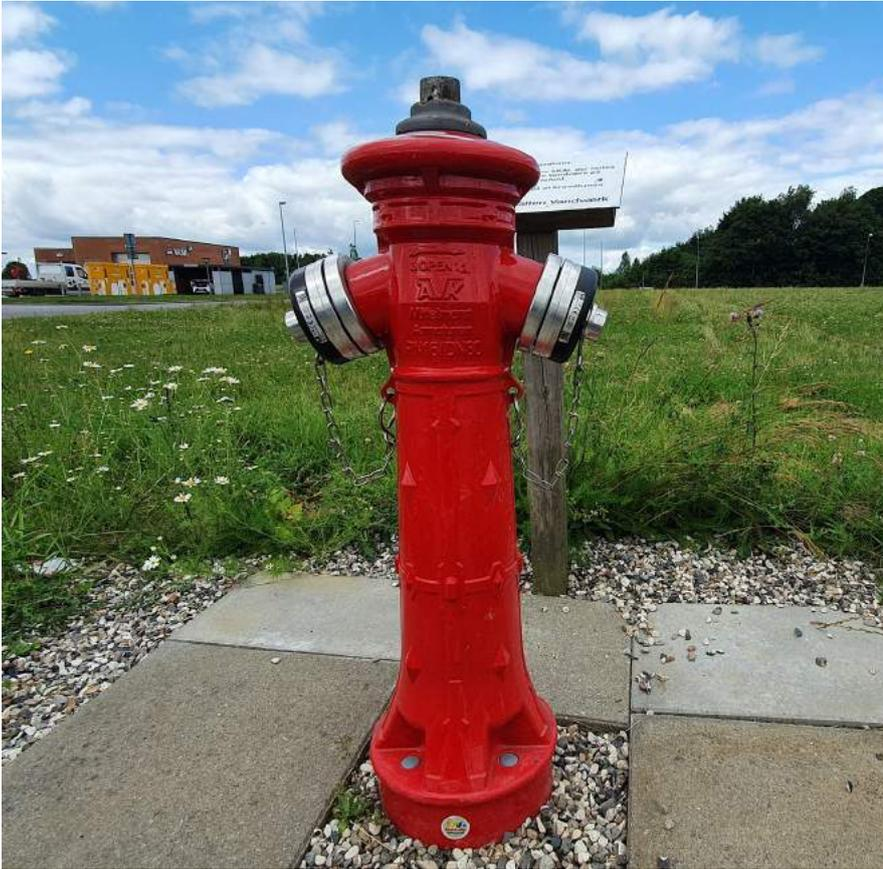
Idrante con tappi VIDI installati. L'uso di un idrante influisce sulla pressione in un'area. Pertanto, è importante che il gestore sappia quando viene utilizzato l'idrante per distinguere tra una caduta di pressione derivante dall'uso regolare o da una rottura del tubo.
